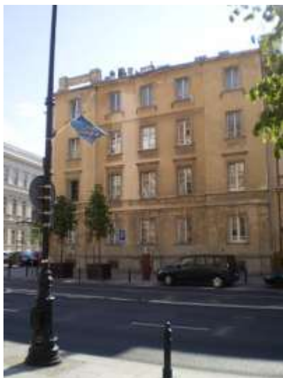
Stan zagospodarowania i otoczenie (budynek Al. Ujazdowskie 43)
