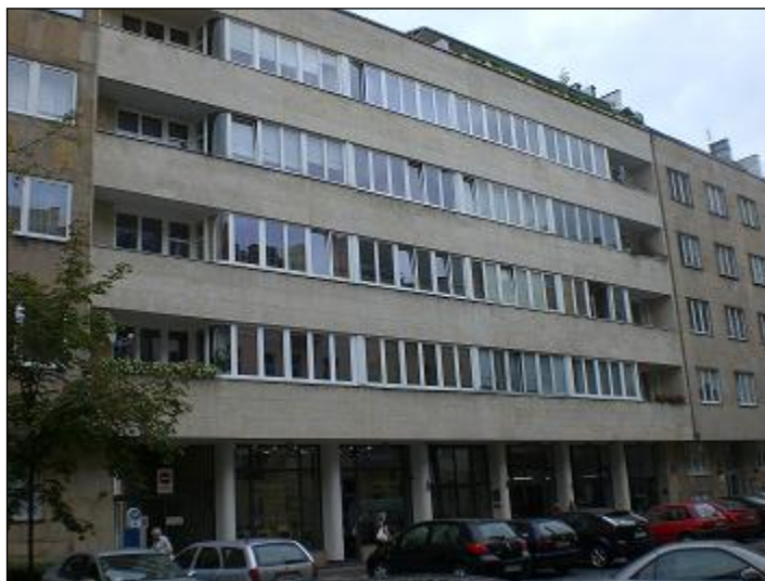
przedmiotowa nieruchomość – frontowa elewacja kamienicy na ul. Wiejskiej 14
